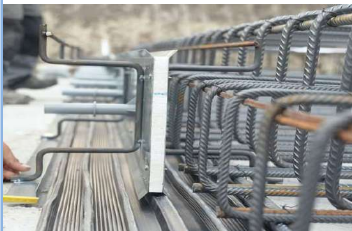
külső és belső dilatációs szalagok elhelyezése kétrészes Fugaform zsaluzati elemmel, nyíróerőtűskékkel
