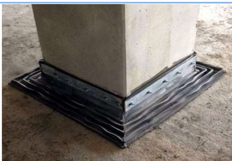
régi-új szerkezet csatlakoztatása szorítóperemes szalaggal és pillér körül előregyártott hegesztett idomokkal
