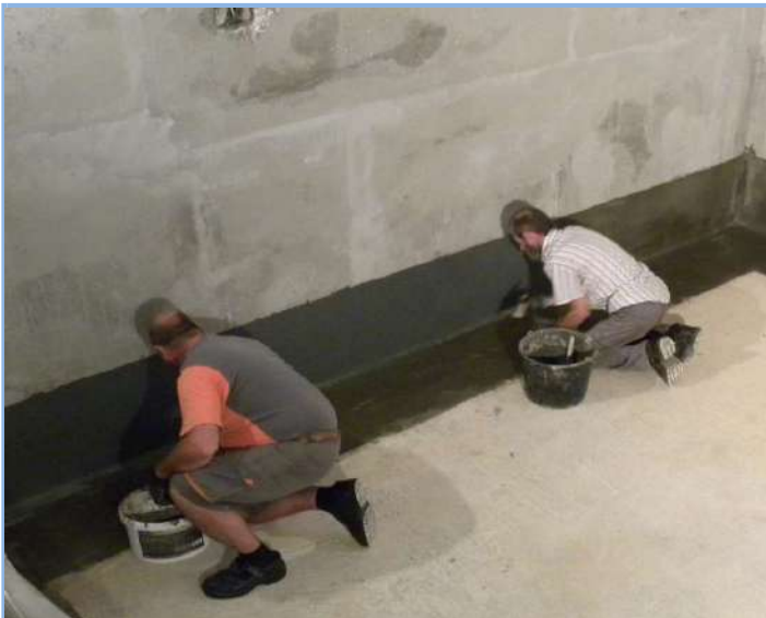
Bostik Block X701 Terra 2K Flex pince vízszigetelése negatív oldalról
