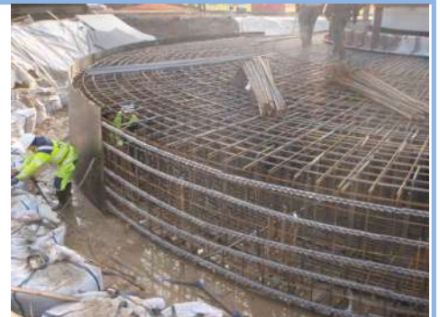
Magas és íves alaplemez kialakítása Ecoform L zsalu használatával
