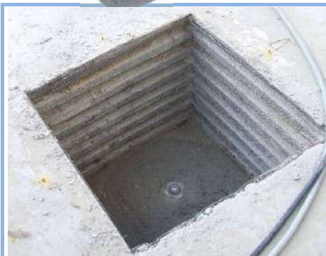
Streckform kehelyzsálat monolit alapon
