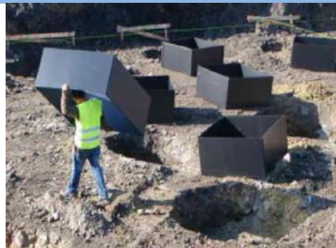
pillérfejek zsaluzása Ecoform pontalapzsalu elemekkel
