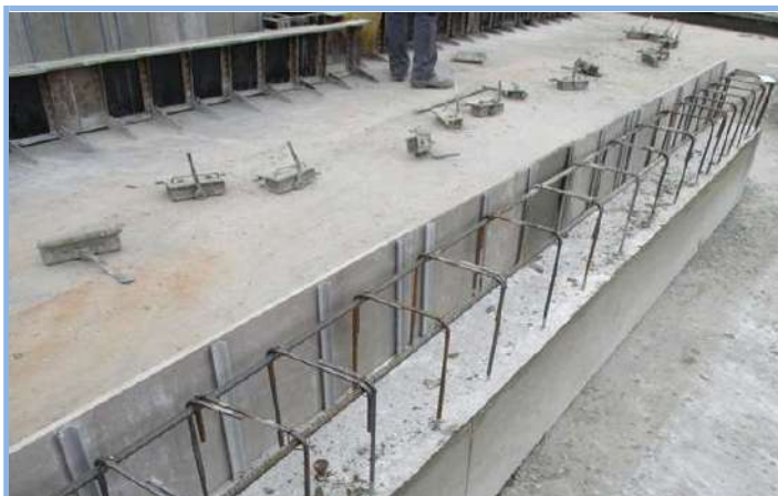
Betobord előregyártott gerendába integrált peremszalu
