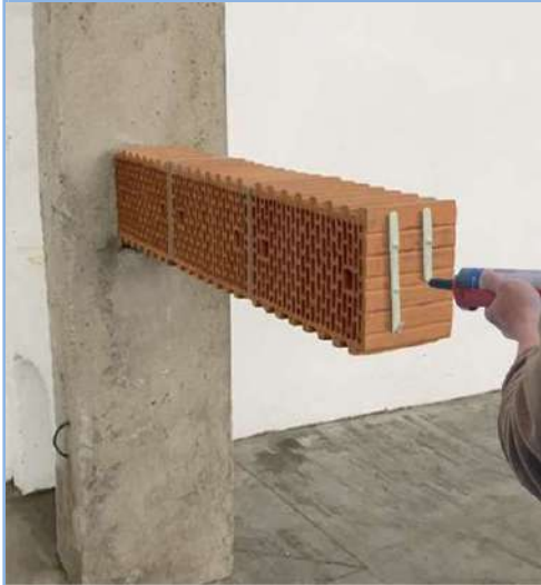
"lebegő" Porotherm téglák falhoz és egymáshoz ragasztva Suprafix MS+ ragasztóval
