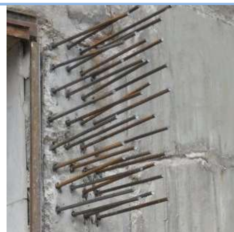
Ø16mm betonacél utólagos be- ragasztása V-Plus tüskeragasztóval
