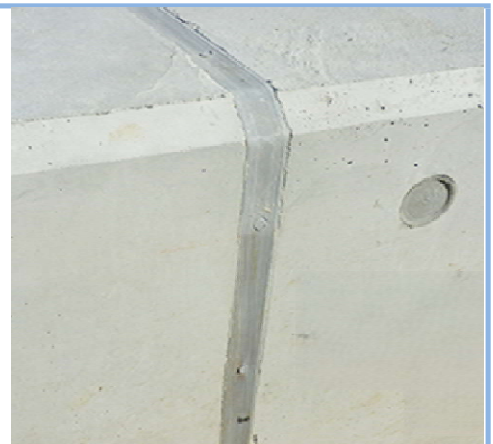
előregyártott betonszerkezet hézagtömítése Bostik Seal'n'Flex masszával
