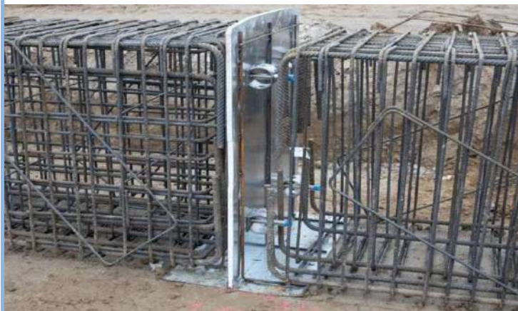
HLD típusú tűskerendszer darupálya dilatációjának teherátadására
