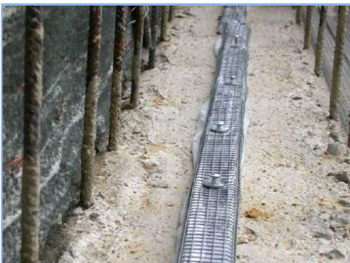
Bautec BT Plus bentonit duzzadószalag betonban oldódó védőfóliával, rögzítőráccsal
