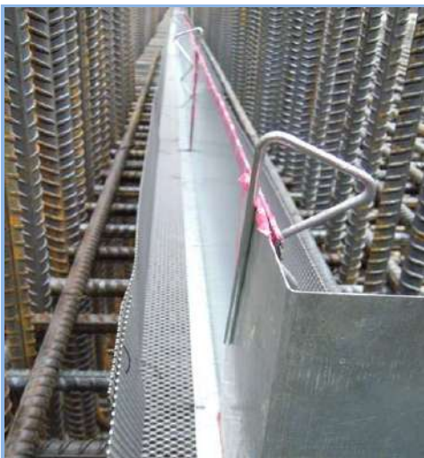
FBK+ bokafalmagasító kosár integrált duzzadóbevonatos lemezzel
