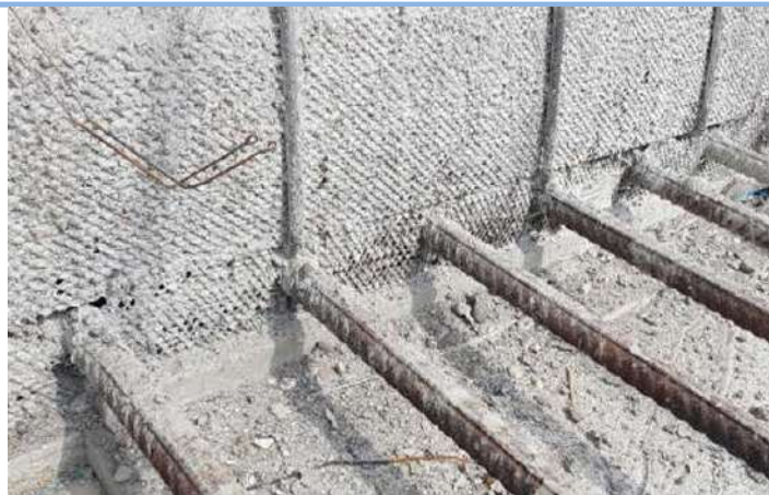
Tiszta munkahézag zsaluzati elem alatt használt Streckform átfolyásgátló távtartóval
