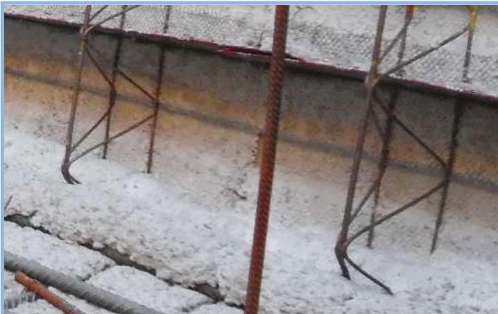
Zsaluzati elem alatt kifolyt beton, melyet utólag szükséges felvésni, tisztítani
