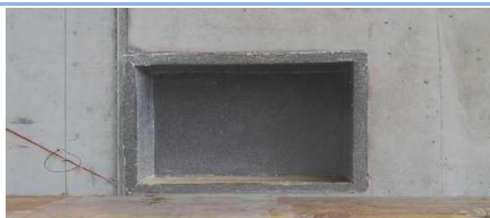
Elasto TBP box pihenőlemez falba történő hanggtátló bekötése
