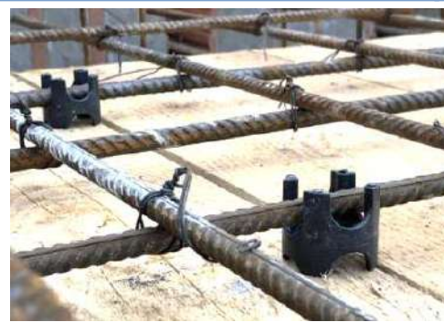
A talpas és hordó távtartókban (karácsonyfa távtartóban is) két ponton fekszik fel a betonacél
