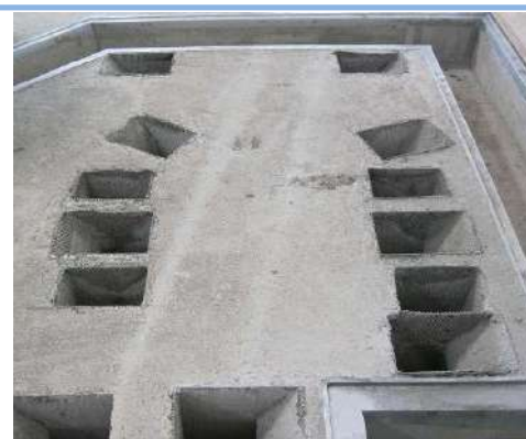
Streckform boxkizárások kiöntőnyílással - betonozás után
