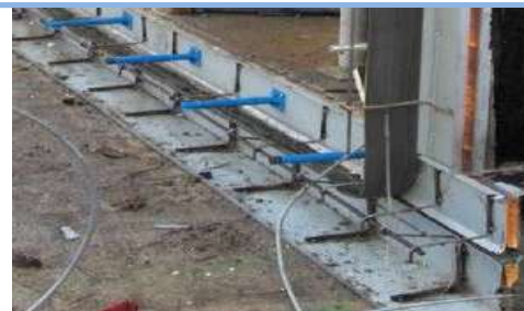
Fugaform DFI belső dilatációs zsaluzati elem síkváltással
