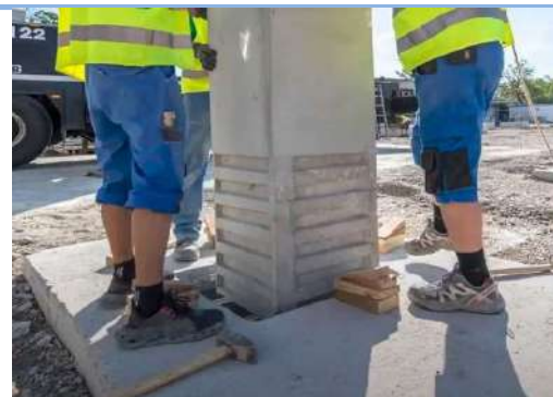
Vasbeton pillér elhelyezése monolit kehelyalapba
