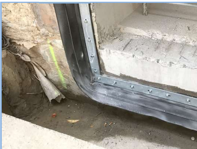
régi-új szerkezet csatlakoztatása szorítóperemes szalaggal és pillér körül előregyártott hegesztett idomokkal
