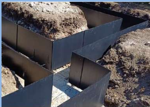
T-csatlakozás és sarokkialakítás kengyelekkel készre szerelt Ecoform sávalapzsalu val
