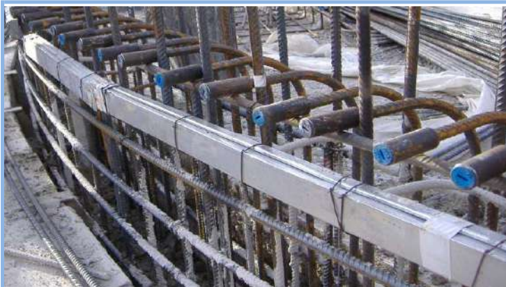
TTS toldás hajlított betonacélon és egyvázás vasalási csatlakozó födém bekötéshez
