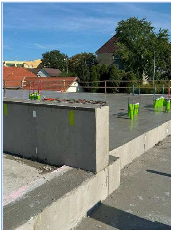
Betobeam MG (magas) 84cm
