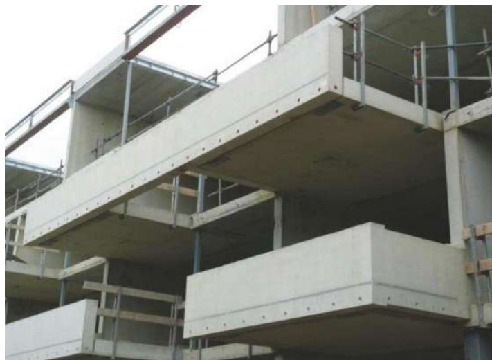
DEMU (T-FIXX) horgonyok erkélyek korlátrögzítéséhez
