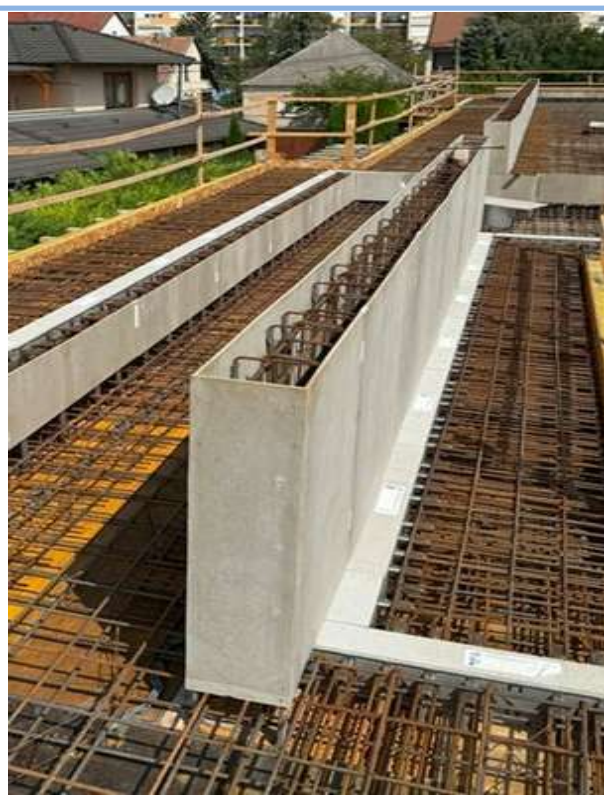
Betobeam MG (extra magas) 105cm
