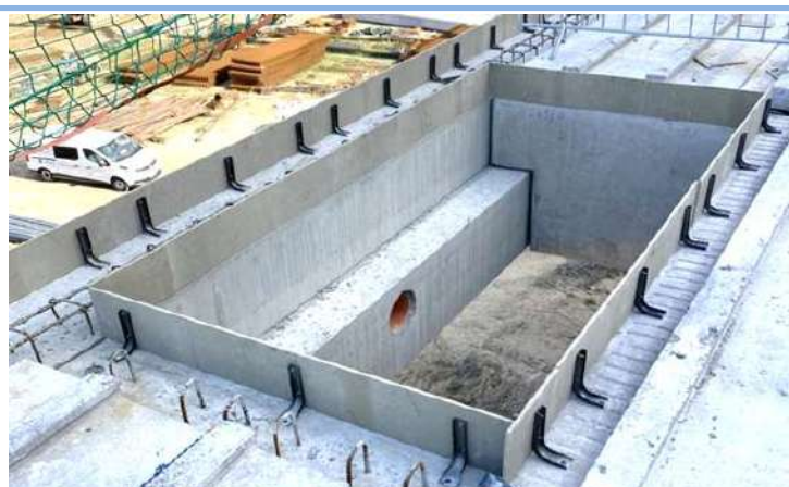
Betobord LS dübeleléssel történő rögzítés után
