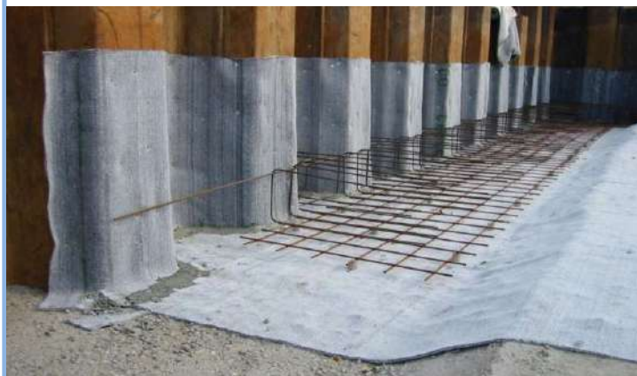
Voltex szigetelés acélszárdpallós...
