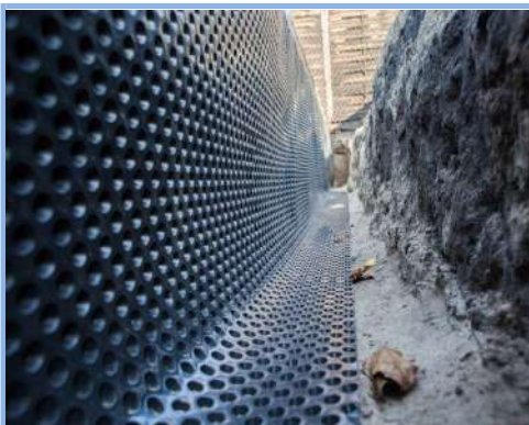
Dréntec 8 lemez alapfal- és szigetelésvédelem
