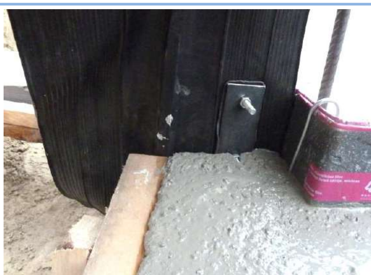
ACB fugaszalag csatlakozó elem dilatációs szalaghoz rögzítve
