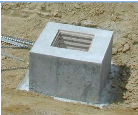
Streckform kehelyzsálat monolit alapon
