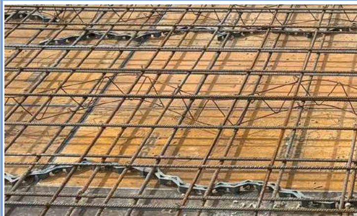
Vasalás Druwa kígyó távtartó és DSL hullámtávtartó használatával
