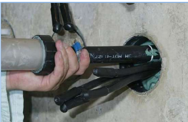
Stopaq 2100 Aquastop kábelátvezetések szigetelése
