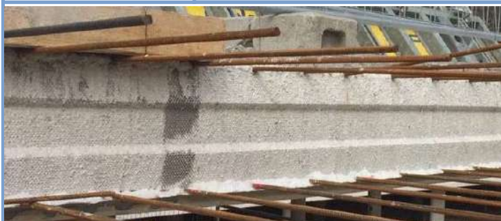
Felüljáró munkahézag kialakítás fogazott Streckform VF elemmel
