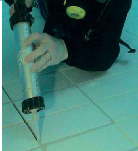
víz alatti csempe ragasztása és fugázása Suprafix MS+ ragasztóval
