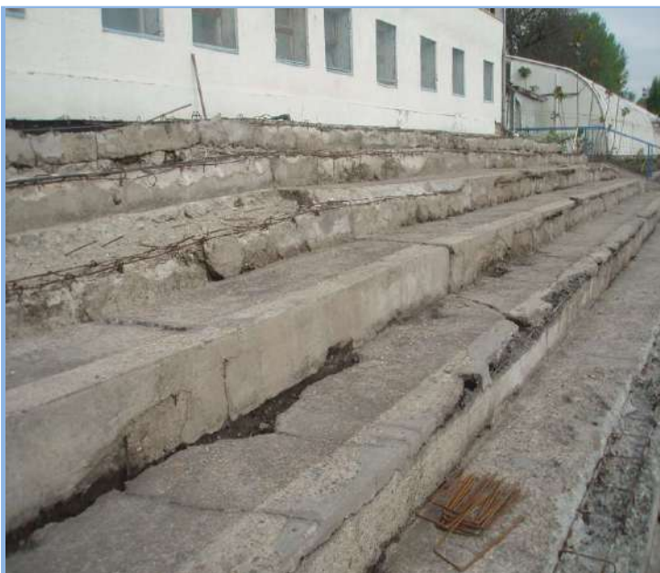
lelátófelújítás Bostik Reno C556 Fill XXL javítóhabarccsal kivitelezés előtt és utána
