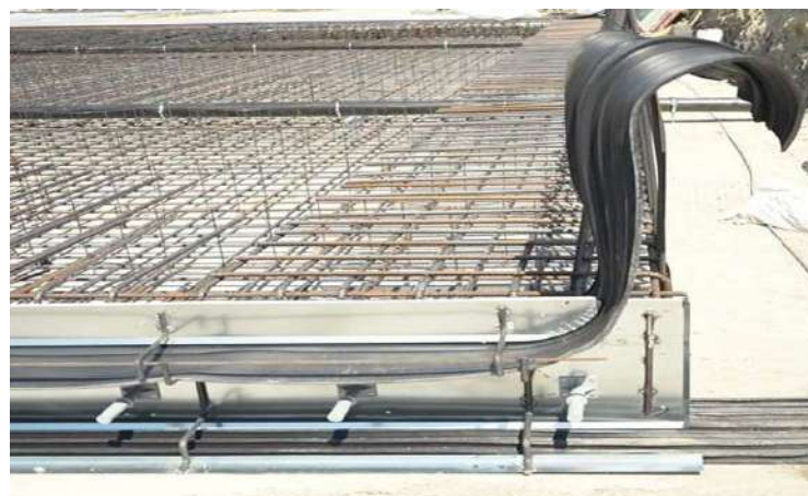
külső és belső dilatációs szalagok elhelyezése kétrészes Fugaform zsaluzati elemmel, nyíróerőtűskékkel
