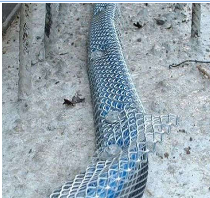
Combiject injektáló- és duzzadószalag keskeny falszerkezetben
