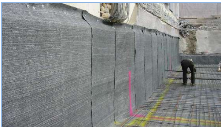
Voltex szigetelés felvezetése résfalon
