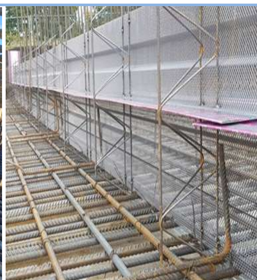
FAS-GT ráccsos merevítésű, fogazott zsaluzati elem
