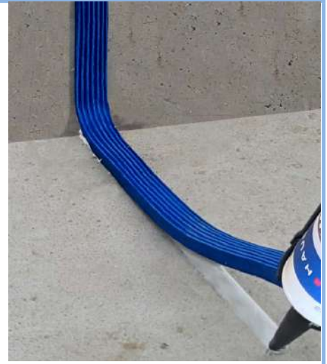
Suprafix MS+ duzzadószalagok rögzítésére vízszintes és függőleges felületen
