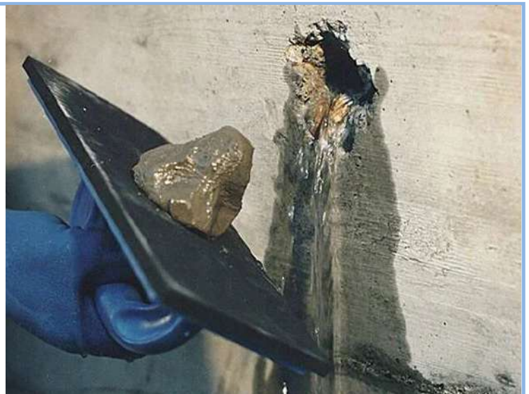
Block C902 Terra Xpress víz folyás mellett másodpercek alatt kötő tömítőhabarcs
