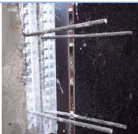
Pyraplex vasalási csatlakozó függőleges falbekötéshez, ritkább vasalással, többletterhelést a dobozgeometria révén
