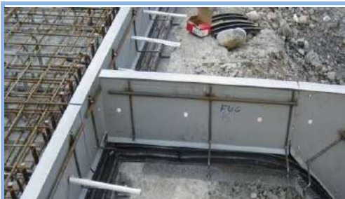
Fugaform DFA külső dilatációs zsaluzati elem térbeli idomcsatlakozással, síkváltással
