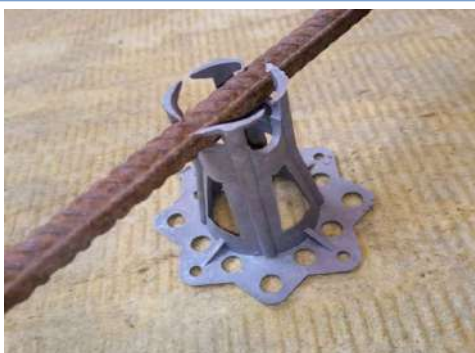
A talpas és hordó távtartókban (karácsonyfa távtartóban is) két ponton fekszik fel a betonacél
