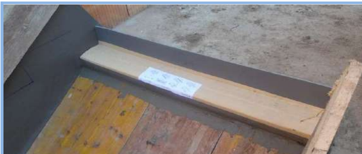
Elasto TBP Z lépcső hanggtátló és Elasto-Foam elválasztó elemek
