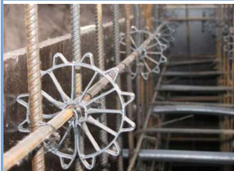
Körtávtartó függőleges vasaltnál
