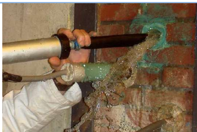
vízátfolyás tömítése Stopaq 2100 Aquastop masszával
