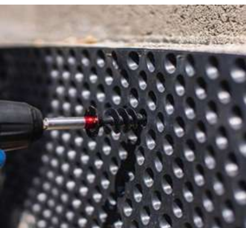
Rögzítés Dréntec spiráldübelrel hőszigetelésen
