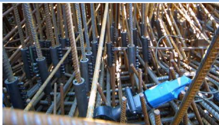
Sűrű vasalás betonacélsatlakozása MBT toldókkal
