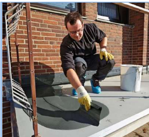
Aqua Blocker teraszszigetelés, lábazatok és csatlakozások tartós és rugalmas szigetelése, javítása
