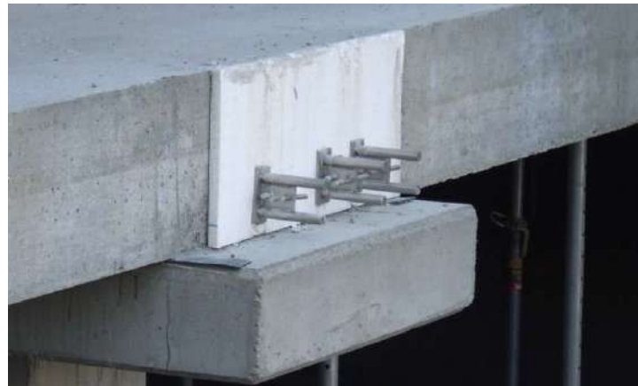
Kis helyen történő extra nagy erők átadása DSD duplatűske rendszerrel
