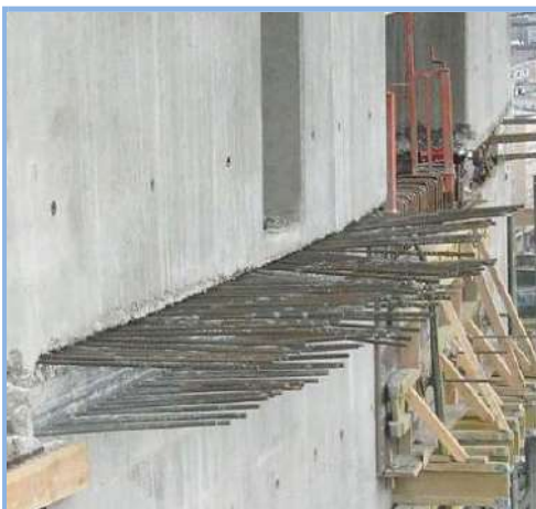
Plexus kengyelváz vasalási csatlakozó vízszintes földmunkakötéssel
