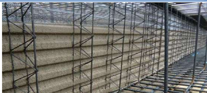
Alaplemez munkahézag kialakítás fogazott Streckform GT elemmel
