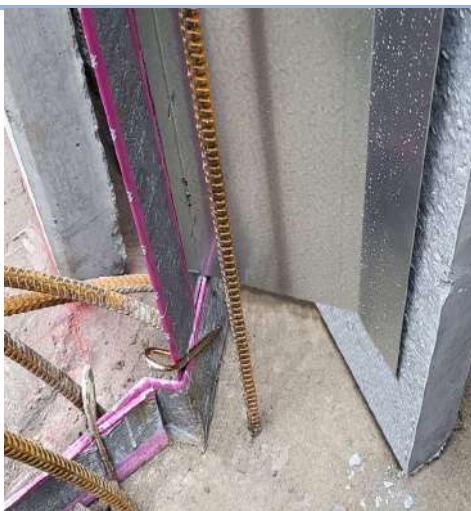
F/AB-S kéregfal sarokelem és ACR-S sarokfugalemez csatlakozás
