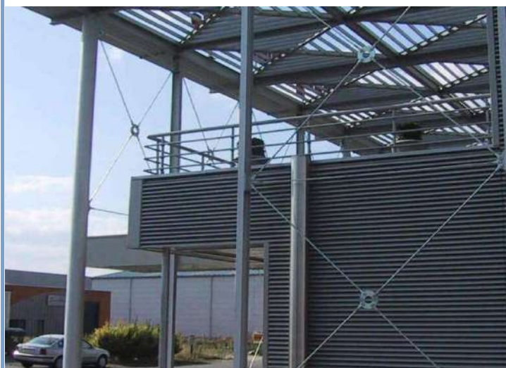
Detan feszítőrúd rendszer keresztmerevítéssel
