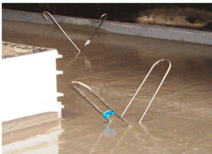
SPA drótanker szendvicspanelek rögzítéséhez
