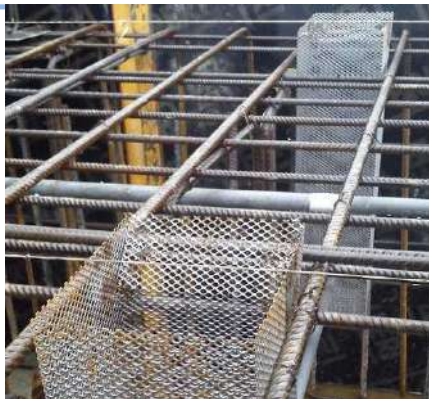
Streckform boxkizárás kiöntőnyílással - elhelyezés után
