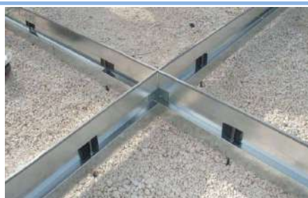
Fugaform XL fogazott (teherátadó) ipari padlóprofil
