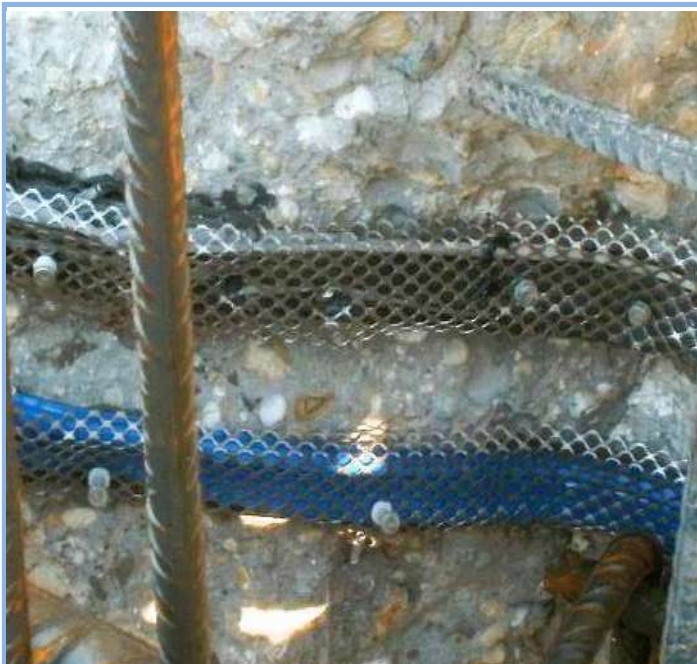
Superject injektálócső és Bautec BT duzzadószalag levéselt függőleges felületen
