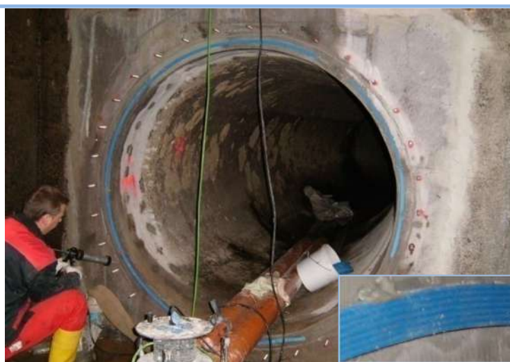
Bautec Swell 10*20mm bordázott duzzadógumi aknaszerkezet csatlakozóhézag szigetelése
