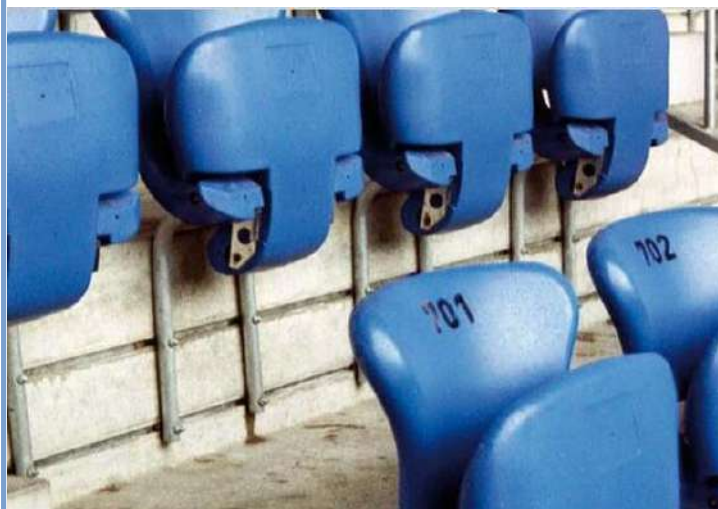
Stadion ülőhelyek rögzítése HTA sínekkel
