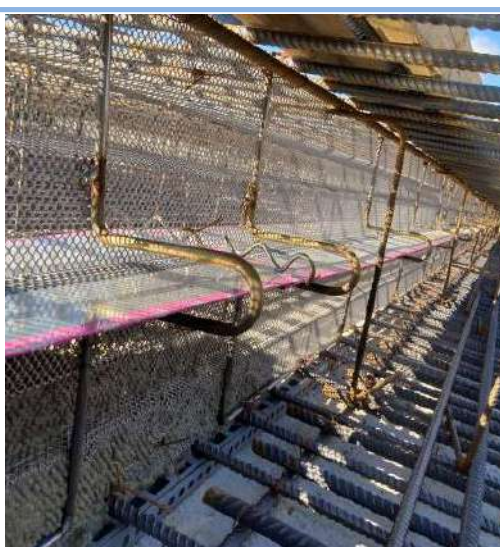
FAS-LB acélbordával merevített, fogazott zsaluzati elem
