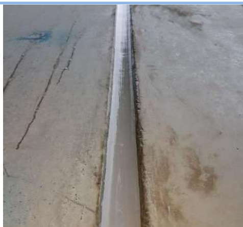
DIN-18540 szerinti magasépítési hézagok és padlófugák rugalmas tömítése Bostik Seal'n'Flex tömítőanyaggal
