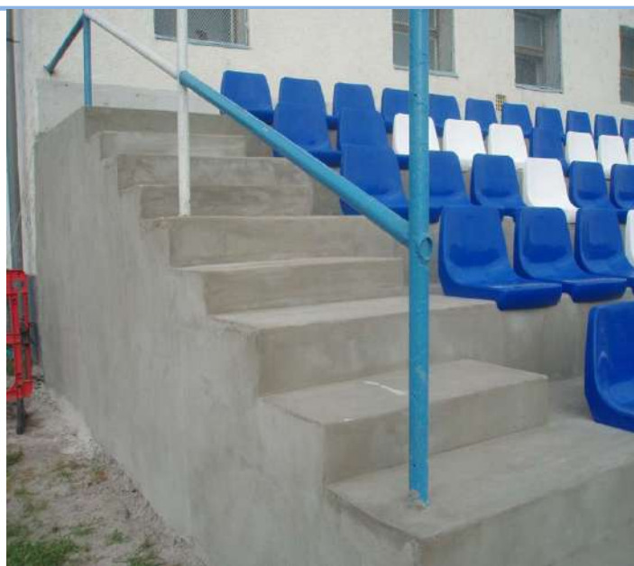
lelátófelújítás Bostik Reno C556 Fill XXL javítóhabarccsal kivitelezés előtt és utána
