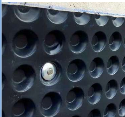
Dréntec 20 nagy vízelvezető képességgel
