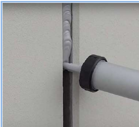
DIN-18540 szerinti magasépítési hézagok és padlófugák rugalmas tömítése Bostik Seal'n'Flex tömítőanyaggal
